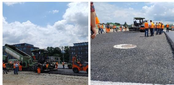
Abbildung 6 Einbau der kalten Tragschicht
