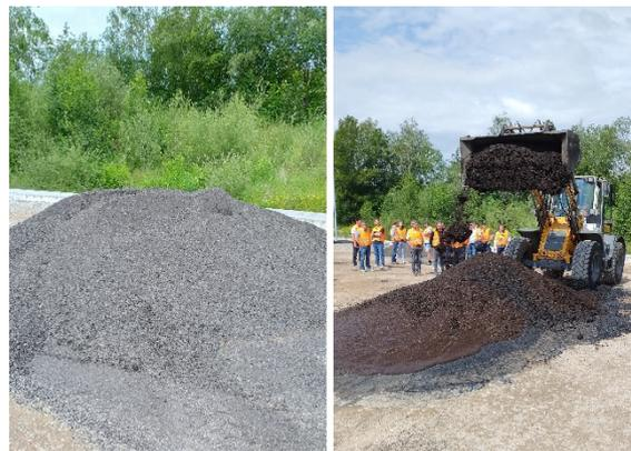
Abbildung 5 In-Situ-Produktion des kalten Mischguts aus Asphaltgranulat und Emulsion. Die frische Mischung erscheint braun und nass. Im Zuge des Brechvorgangs wird das Gemisch krümelig, rieselfähig und erscheint schwarz.
